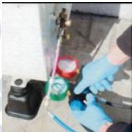
**Paso 3 - Abra la válvula de la garrafa de gas refrigerante para sacar el posible aire de la manguera de carga.** Rápidamente conecte la manguera de carga a Easy-Inject. Inyecte el gas refrigerante a través de Easy-inject y añada ULTRA dentro del sistema A/C.
